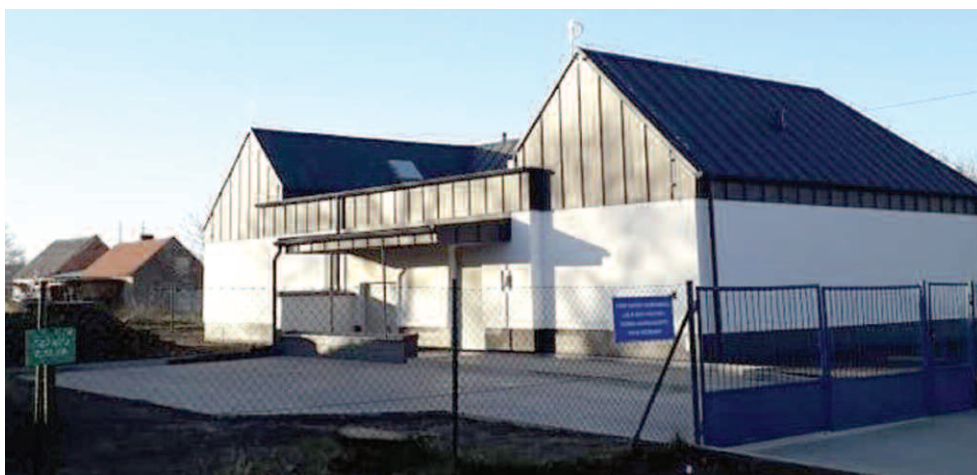
>>> Oczyszczalnia ścieków w Drzonowie
